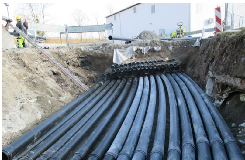
Bilder oben: Erneuerung einer Gasleitung, Stuttgart.
