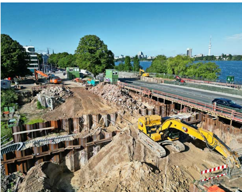
Baustelle Hohenfelder Bucht.
