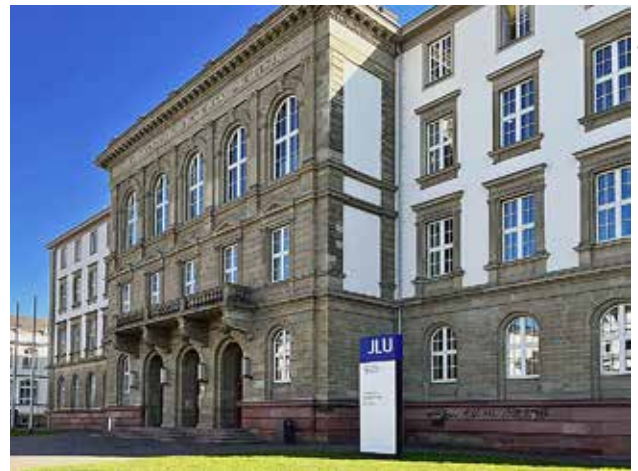
Universität Gießen: Facility Management mit System.
