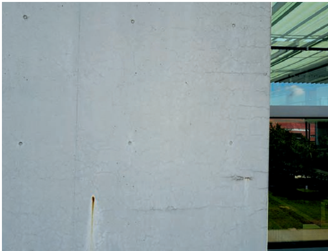
Abb. 4: Hochauflösende, durch Drohnen aufgenommene Bilddateien können wertvolle Informationen zu Rissen im Beton liefern
