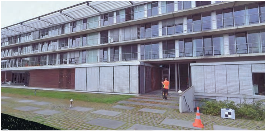
Abb. 2: Sämtliche Aufnahmen können dank moderner Technologie von außen erfolgen – Die Ingenieure müssen das Gebäude für Vermessungsarbeiten nicht betreten
