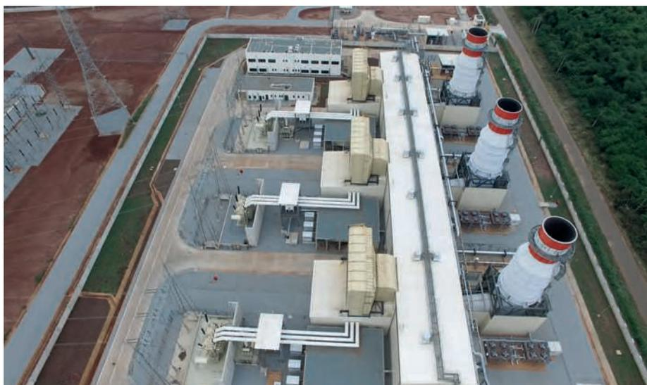
Abb. 2: In Bauphase 1 wurde die Turbinenhalle für insgesamt drei Turbinen mit je 150 MW Leistung inklusive der erforderlichen Peripherie-Gebäude und der Infrastruktur fertiggestellt
