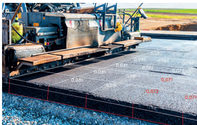
Abb. 1: Bei der Sanierung eines 6 km langen Teilstücks der BAB A 8 wurde eine Analyse der Schichtdicken während und nach Bauausführung sowie eine Baustellendokumentation und Berechnung von verbauten Massen und Mengen vorgenommen
