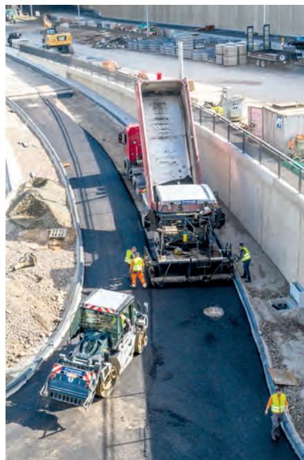
Abb. 1: Bei Bauaufgaben, bei denen größere Mengen (Kies, Sand, Asphalt oder Beton) verbaut werden, bringt das Abgleichen von Lieferscheinen und zugehörigen Rechnungen einen großen Aufwand mit sich
