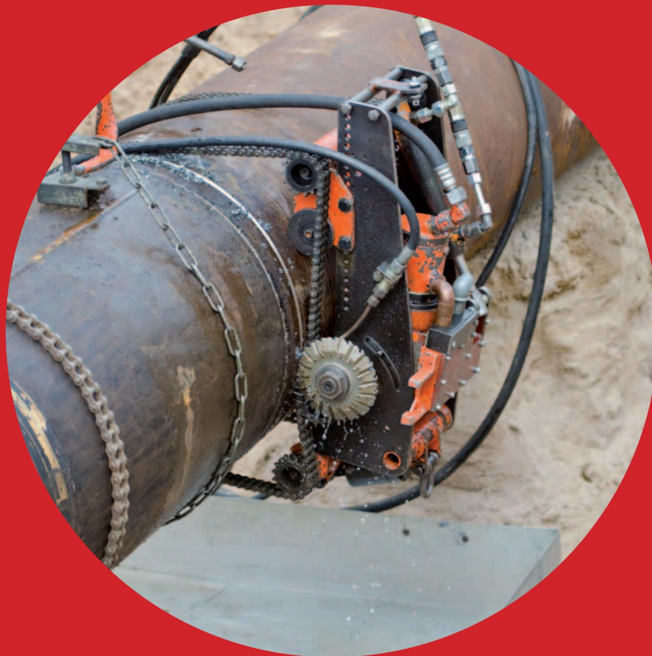
Mit Trennschnitten an schadhaften Rohren öffnet Pipeoline Segmente, die Fachfirmen mit neuen Bauteilen im nächsten Schritt ergänzen. Das Pipeoline-eigene Spezialverfahren mit ferngesteuerten Sägen bietet echte Arbeitssicherheit. Die Mitarbeiter halten sich bei der Durchführung von Trennschnitten außerhalb des Gefahrenbereichs auf.
