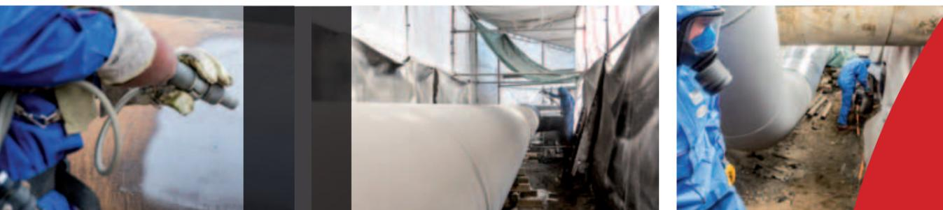
Zur Entfernung ausgedienter und beschädigter Isolierungen von Stahlrohrleitungen führen wir Sand- und Wasserstrahlarbeiten durch. Unsere Mitarbeiter sind qualifiziert und zertifiziert für die Abstrahlung von asbesthaltigen Bitumenisolierungen.
